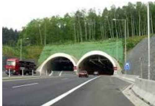
Tunel Valík, Česká Republika
